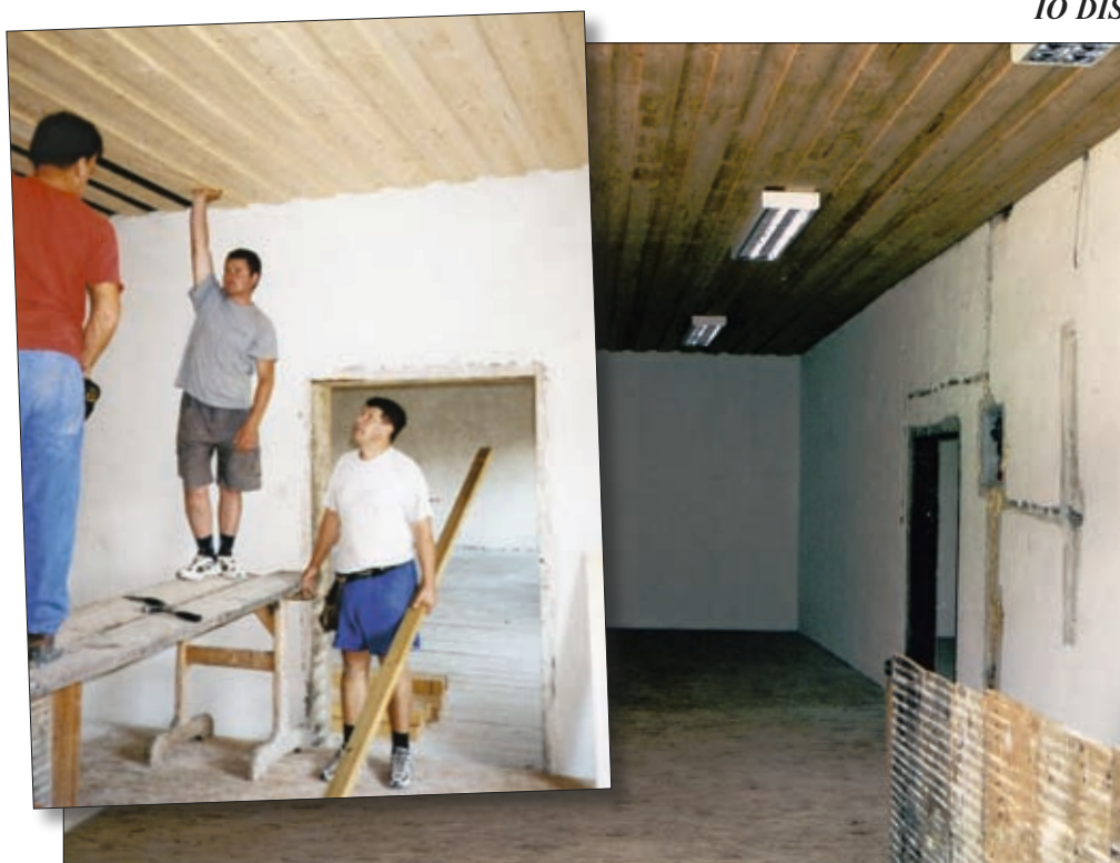
Delna obnova zgornjih prostorov taborišča v Brestanici
