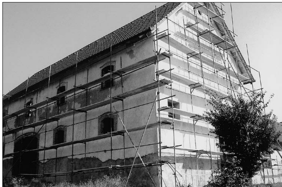
Ves avgust in september so potekala dela za obnovo fasade tudi na velikem delu taborišča. (1. 10. 2006) Foto: Alojz Rupar
