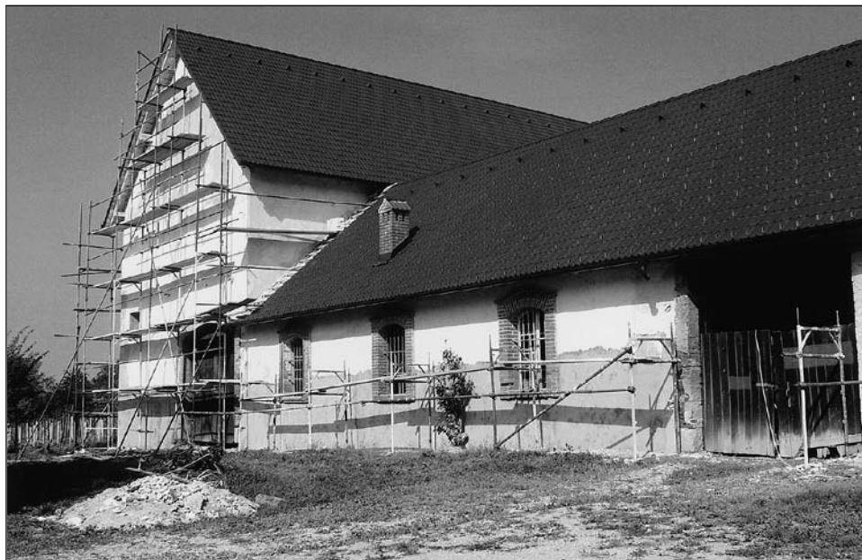
Leta 2005 je bilo obnovljeno ostrešje in streha hlevov – zbirnega taborišča za izgon Slovencev, sedaj pa obnavljajo fasado celotnega objekta. Foto: A. Rupar
